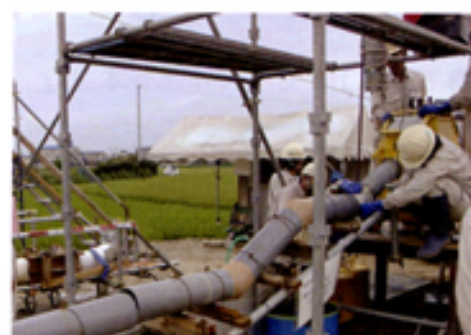
取付管施工状況
