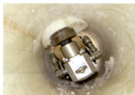
本管内突出部切除工
