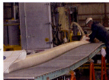
材料調整工状況
